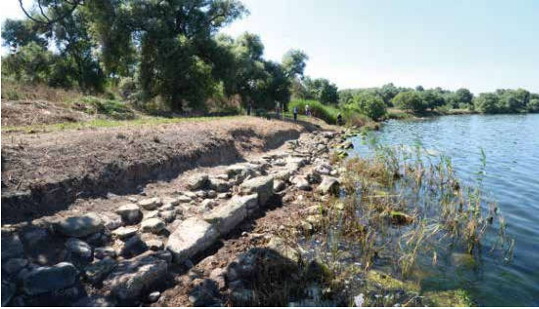
Resim 3: Sahil duvarlarının kazı sonrası ortaya çıkarılmış bir bölümü.
