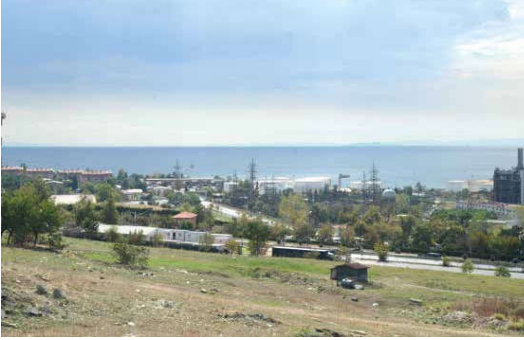
Res. 9: Ambarlı'da yer alan dolum ve enerji üretim tesisleri.
