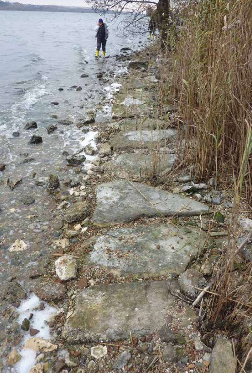
Res. 25a: Küçükçekmece Göl Havzasında (Bathonea) tespit edilen kıyı duvarları.
