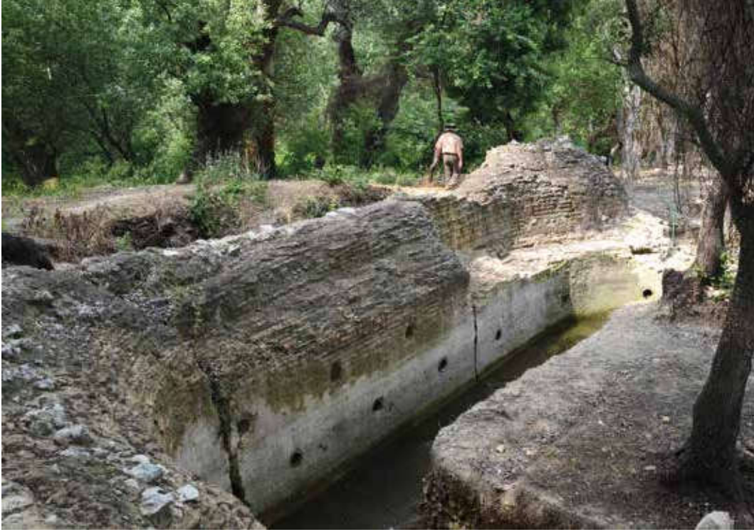
Res. 28: Açık sarnığın kısa duvarı
