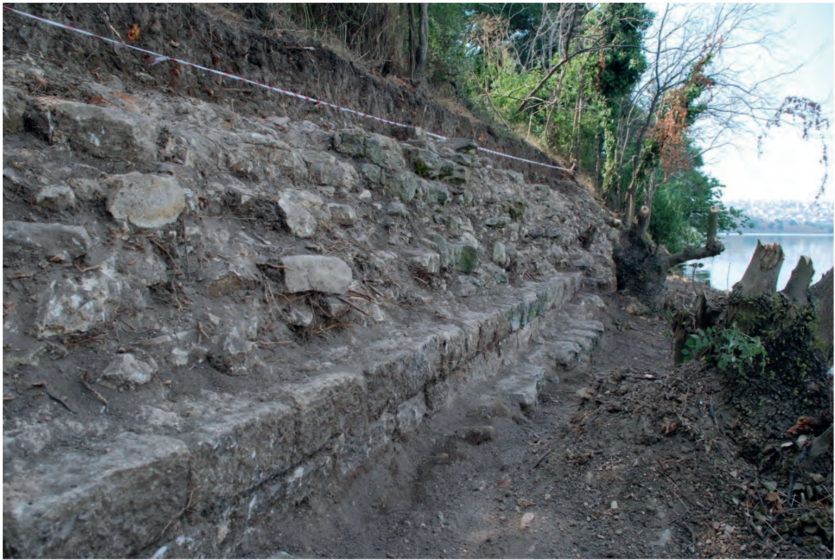
Res. 41: Alttan birkaç sıra korunmuş kesme taş blokları kalmış kıyı duvarı.
