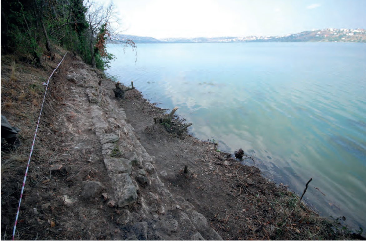
Res. 42: Kıyı duvarının yukarıdan görüntüsü. Fig. 42: Coastal wall seen from above
