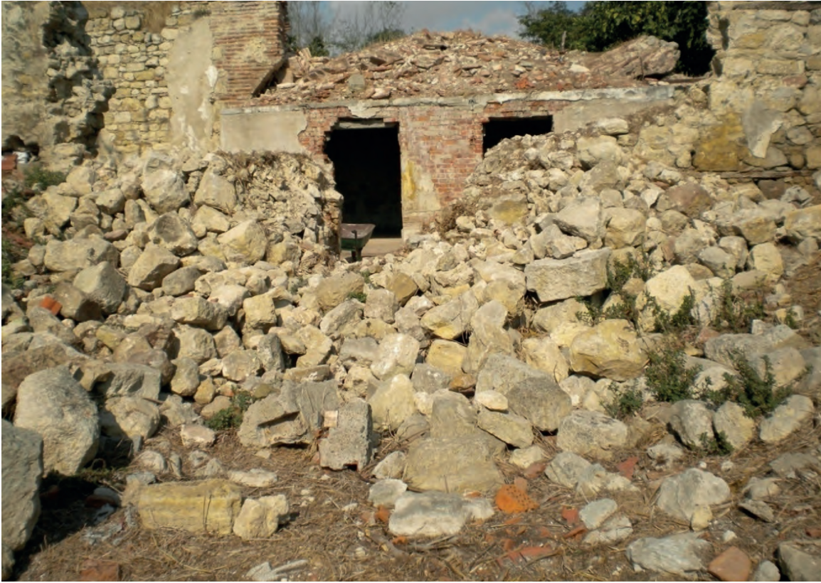
Res. 90a: Osmanlı çiftlik yapılarında temizlik çalışmaları öncesi. Fig. 90a: Late Ottoman farm buildings before cleaning.
