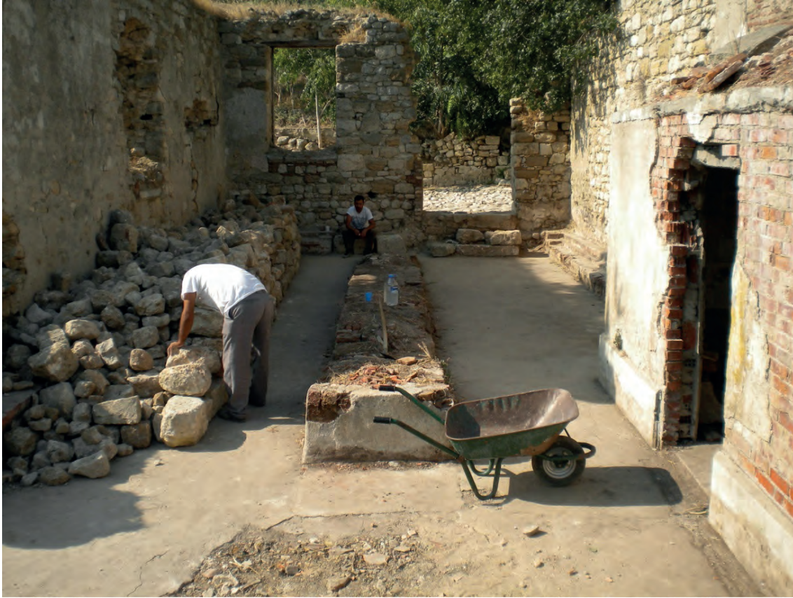
Res. 90b: Osmanlı çiftlik yapılarında temizlik çalışmaları sonrası.
