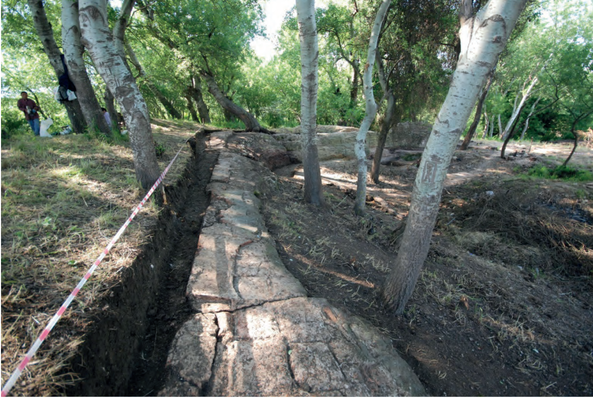
Res. 8: Büyük sarnıç duvar takip kazısı.
