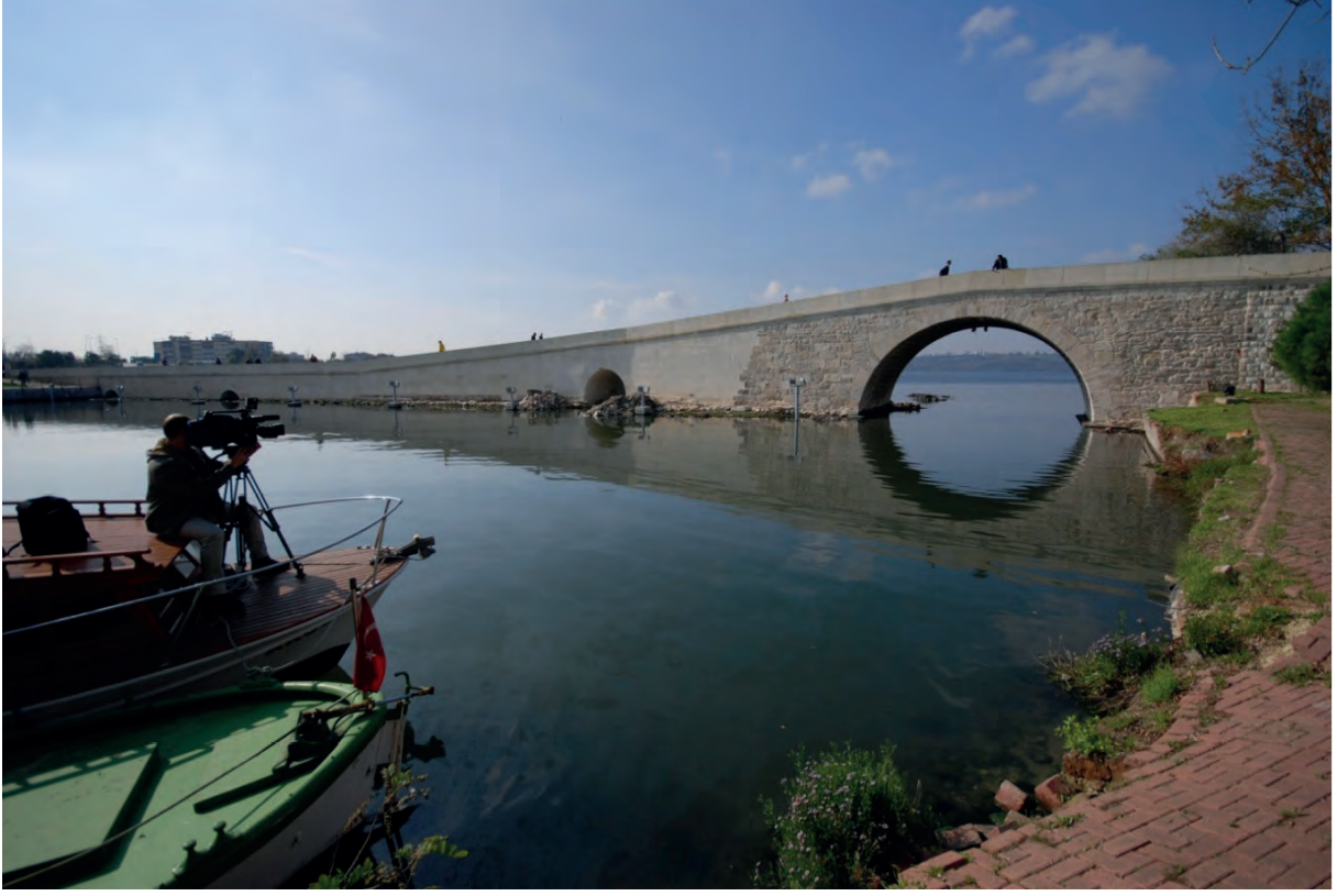
Res. 104: Menekşe(Mrymex) kanalın göle açılan bölümünde yer alan taş köprü. Fig. 104: The stone bridge in the opening section of Menekşe(Mrymex) channel to the lake.
