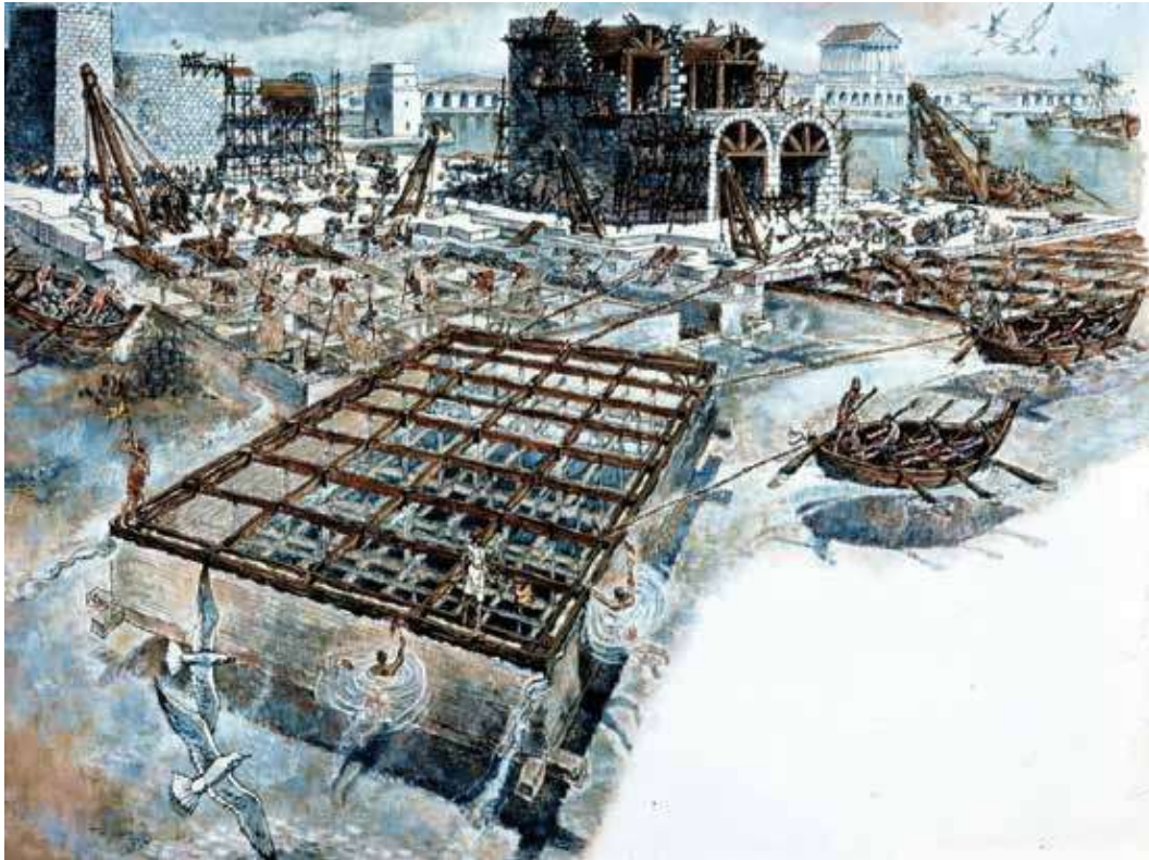
Şek. 10: Keson yerleştirme (Brandon, vd., 2014) Fig. 10: The placing of caissons (after Brandon, et. al, 2014)
