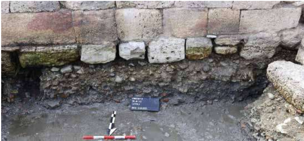
Şek. 12: Sağlam durumda ve homojen temel (Fotoğraf: A. Ginalis) Fig. 12: The solid and homogeneous foundation (Photograph: A. Ginalis)
