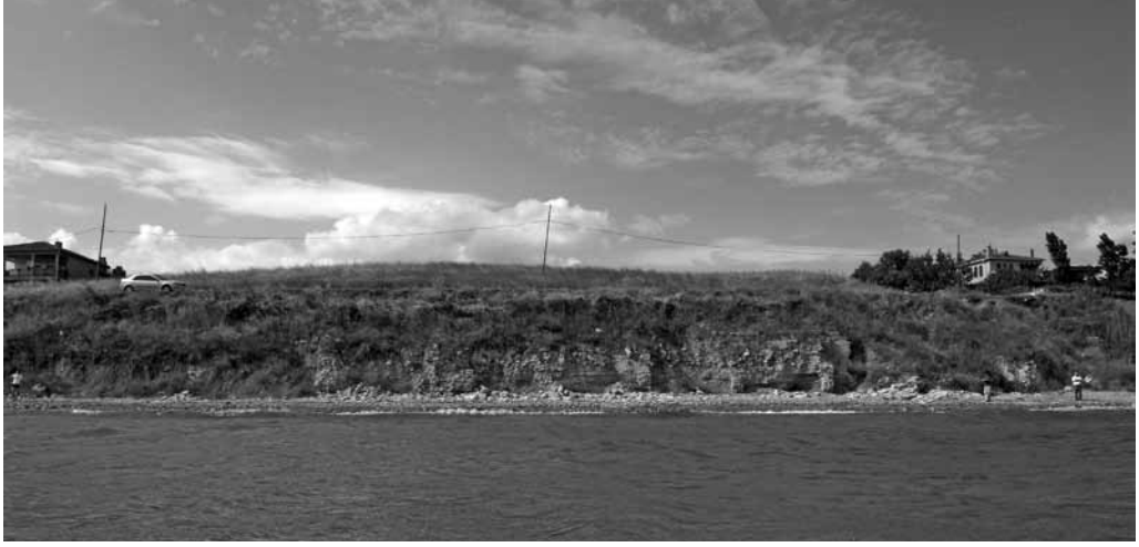
Res. 1: Beylikdüzü'nde bulunan kıyı yapısının 2011- 2012 yıllarındaki durumu.
